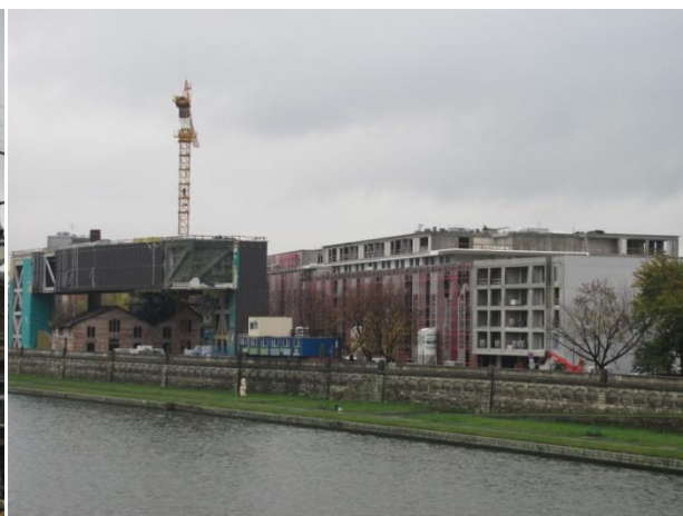
Zdjęcie 13. Budowa Muzeum Tadeusza Kantora
