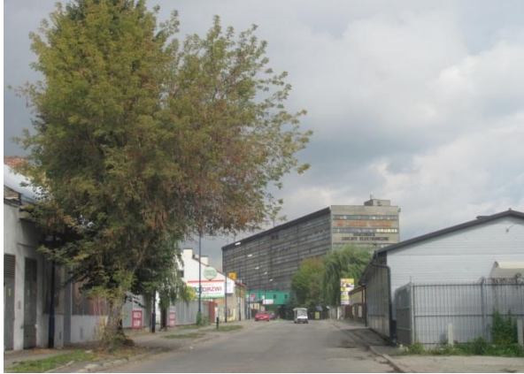
Zdjęcie 17. Stan techniczny zabudowy – ul. Romanowicza
