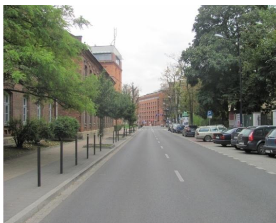
Zdjęcie 7. Przebudowana ul. Szlak
