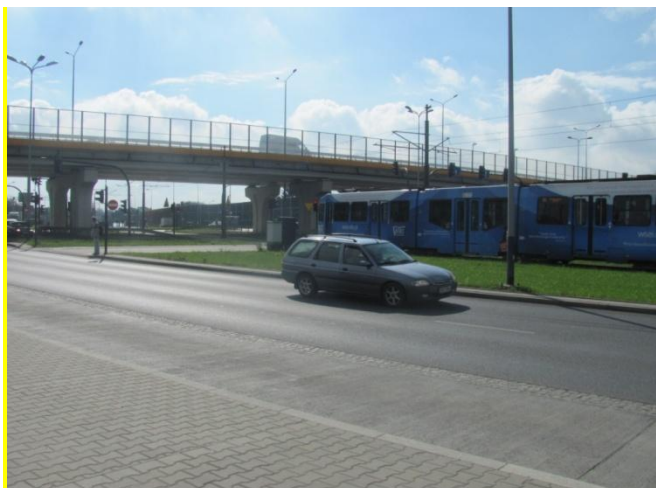
Fot. 19. Dwupoziomowe skrzyżowanie ul. Nowohuckiej z ul. Kuklińskiego / Surzyckiego
