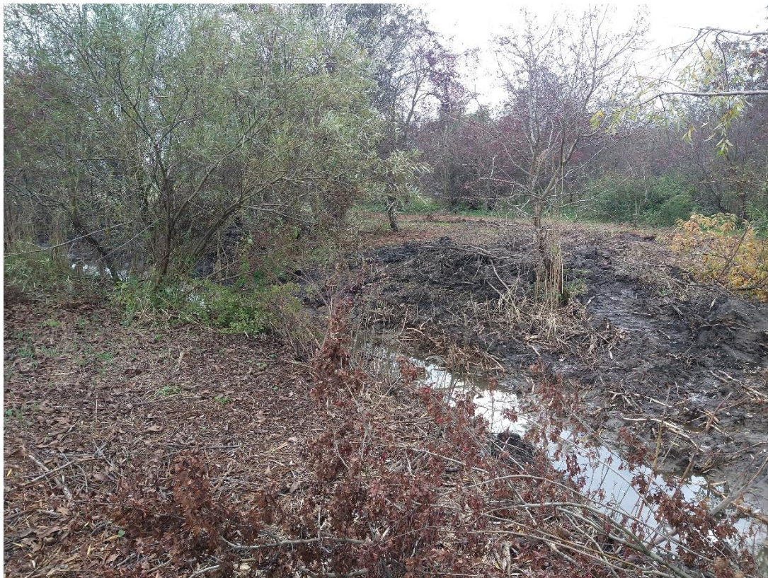
Fot. 3. Wycięta roślinność i rozkopane naturalne koryto ciek w rejonie pomiędzy enklawami nr 3 i nr 4
