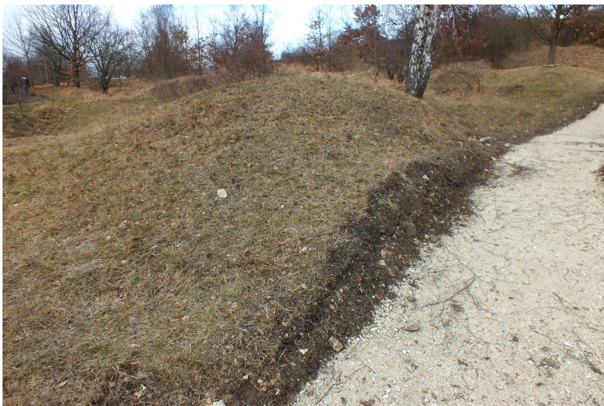
Fot. 6. Ścieżka w miejscu sasanek, wybrano wierzchnią warstwę gleby i wypełniono nawierzchnią z pokruszonych skał – 5.02.2022 r.
